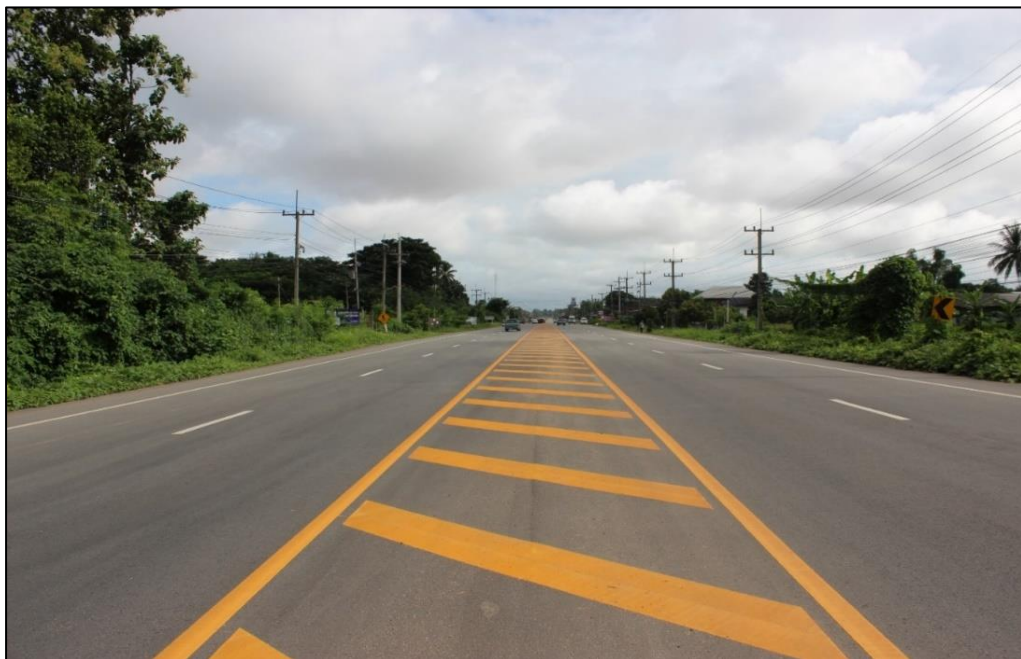
รูปที่ 6-2 ตำแหน่งและสภาพพื้นที่จุดเริ่มต้นโครงการ (ทล. 201 กม. 393+400)
