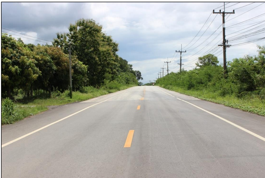
รูปที่ 6-3 ตำแหน่งและสภาพพื้นที่จุดสิ้นสุดโครงการ (ทล. 211 กม. 181+000)
